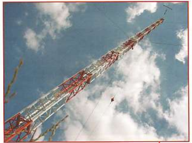
Eén mast van de 147 kHz antenne
